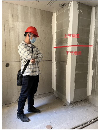
图3 每层楼烟道由两节拼成
