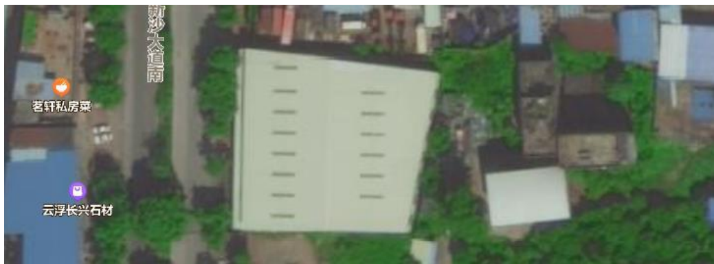
图 4、钢结构厂房俯视图
