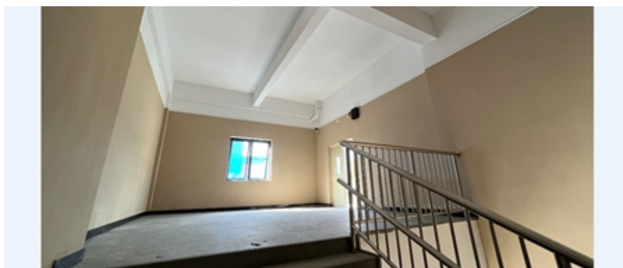
图 2 B2 淋浴楼 4 层楼梯间平台
