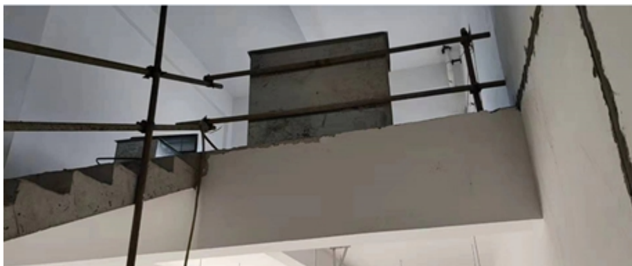
图4 楼梯平台临边防护（钢管）情况
