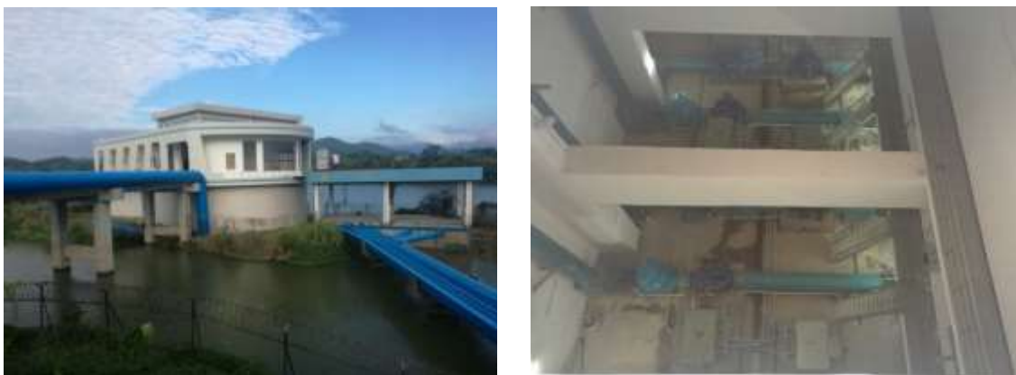
图 3.4-2 现状柯灯山取水泵站
